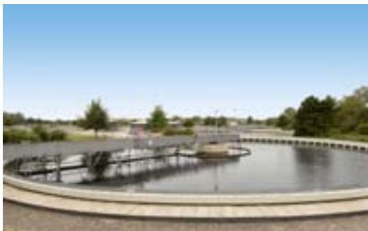
Nachklärbecken auf dem Klärwerk Steinhof
