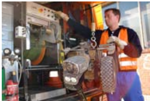
Kamera für die Überprüfung der Abflusskanäle
